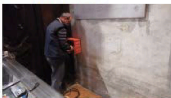
Fig. 14 Acquisizione radar della linea 2, controfacciata sinistra.
