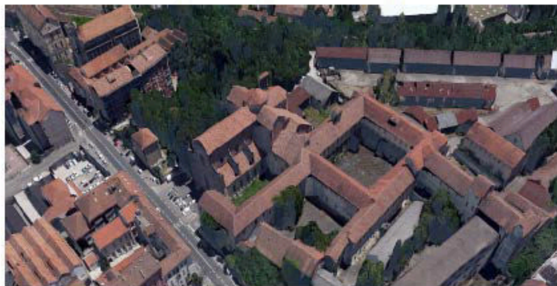
Fig. 1 - Vista aerea della Chiesa San Salvatore estratta Google Earth
